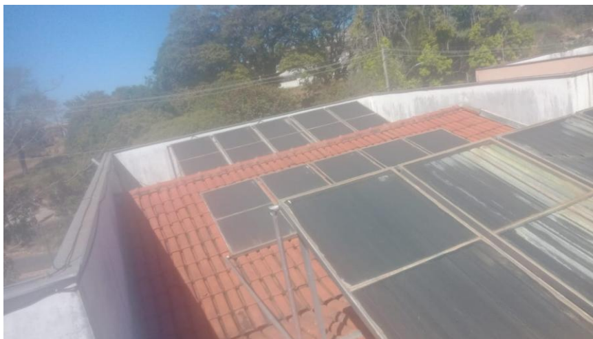
Imagem 3 – Coletores solares danificados instalados em telhas da cobertura
