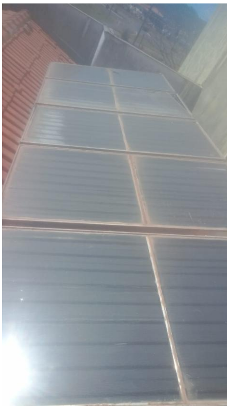
Imagem 5 – Coletores solares danificados instalados em telhas da cobertura
