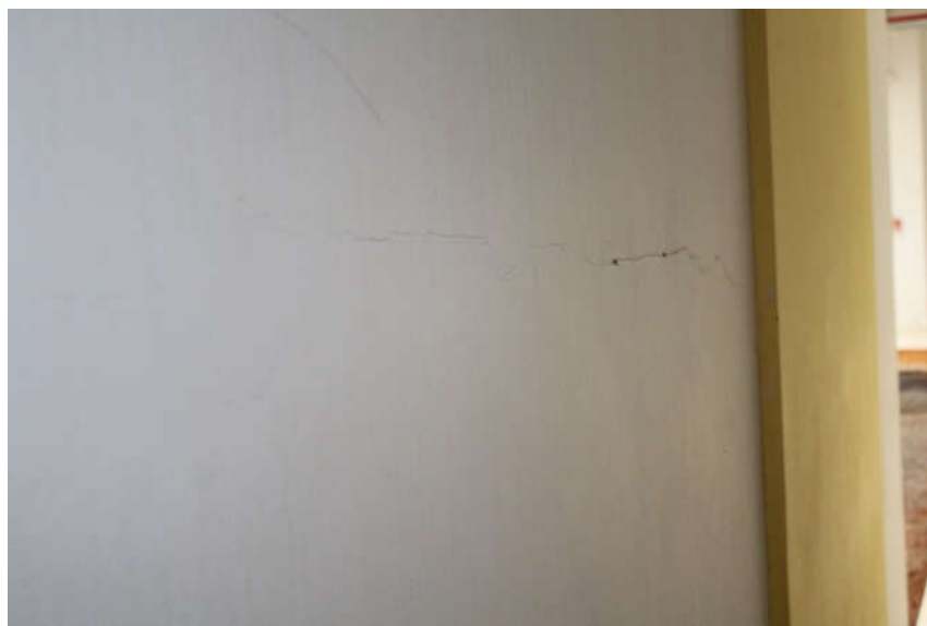
Figura 27: Trinca em alvenaria em vários locais, ocasionada provavelmente pela ausência de amarração dos blocos cerâmicos.
