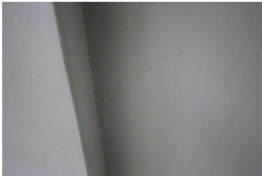
Figura 27: Trinca em alvenaria em vários locais, ocasionada provavelmente pela ausência de amarração dos blocos cerâmicos.
