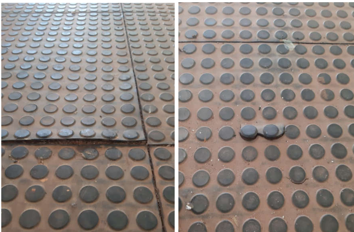
Figura20: Placa do piso emborrachado danificada: (a) Placadescolando e (b) Necessita de substituição.
