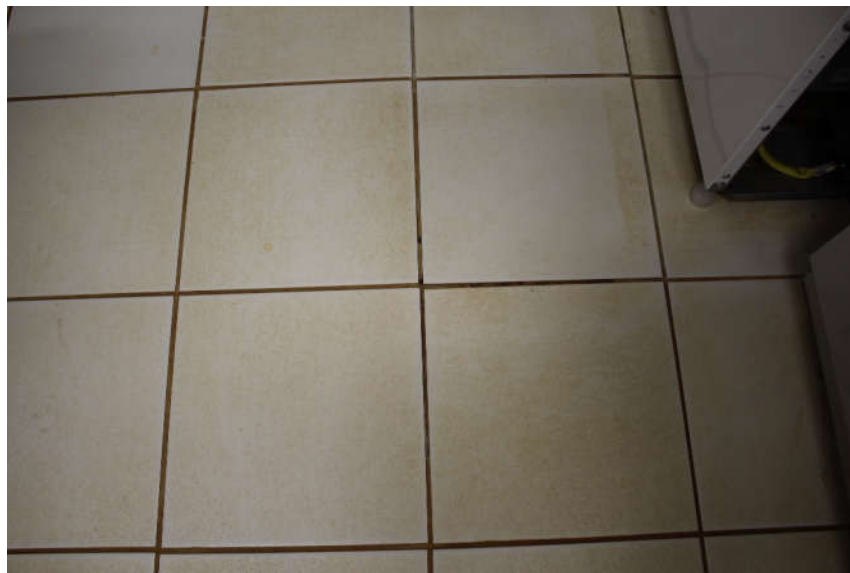
Figura 12: Manchas nas peças cerâmicas.
