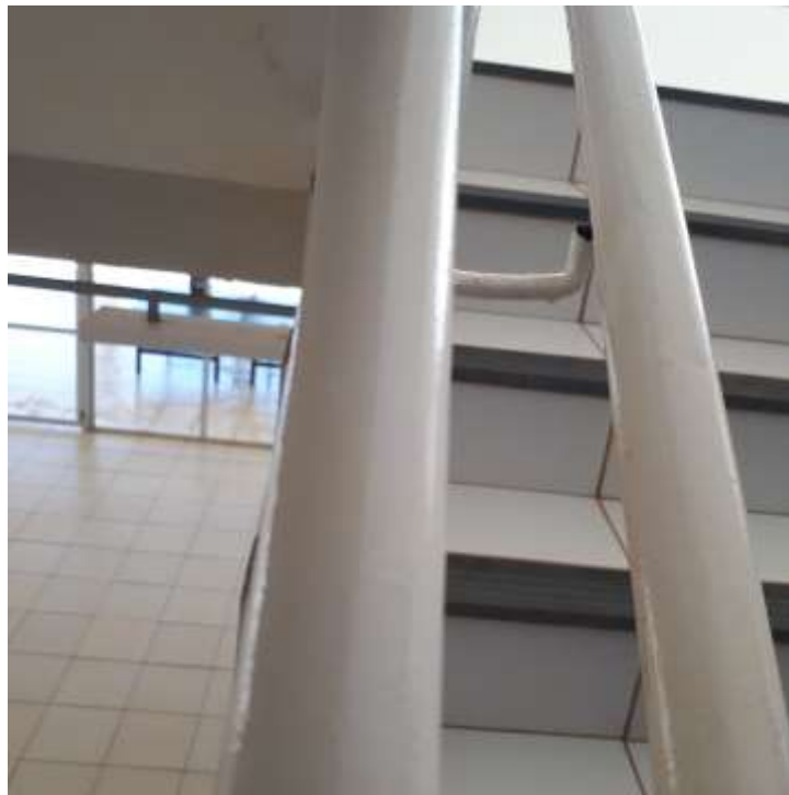
Figura 18: Corrimão / Guarda-Corpos rampas de Acesso aos pavimentos
