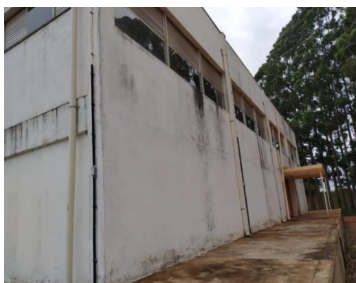
Figura 20: Fachada externa do prédio do Almoarifado.
