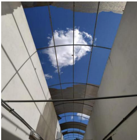
Figura 40: Cobertura em um dos corredores do Prédio II – Campus II
