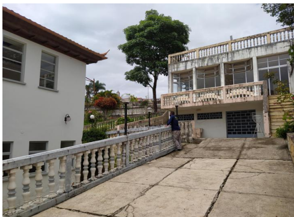
Figura 46: Balaustres da área de Convivência. Campus I.
