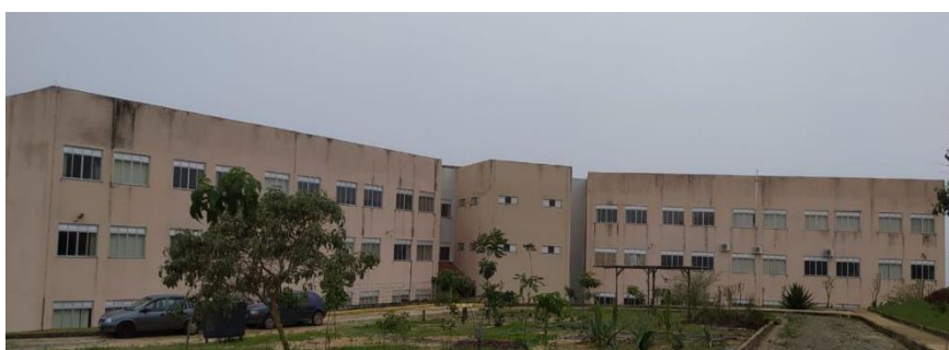
Figura 06: Fachada Externa do Prédio do DCBio - Campus JK.
