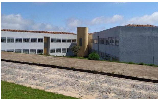
Figura 18: Fachada externa do Prédio (FIH).
