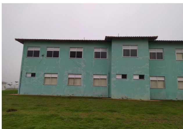
Figura 12: Fachada externa do Prédio da Fisioterapia – Campus JK.
