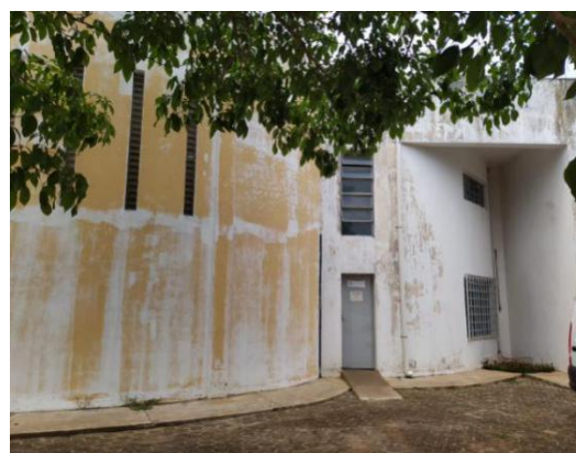
Figura 21: Fachada externa do prédio do Almoarifado.
