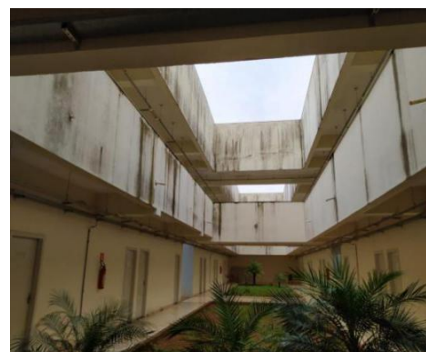
Figura 19: Fachada interna do Prédio Administrativo da FIH.
