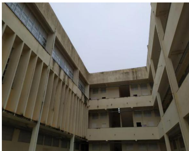
Figura 32: Fachada interna do prédio do ICT. Campus JK.
