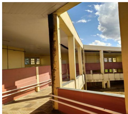
Figura 03: Fachada interna do Pavilhão de Auditórios – Campus JK.
