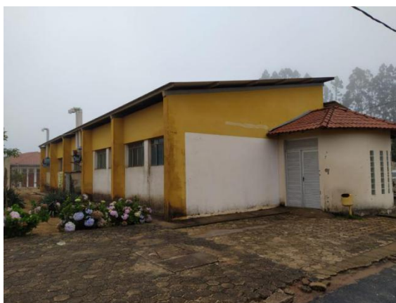
Foto 28 - Fachada Externa do Prédio da Química
