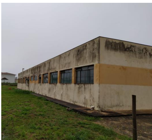
Figura 26: Fachada externa do prédio LPP JEQUI.
