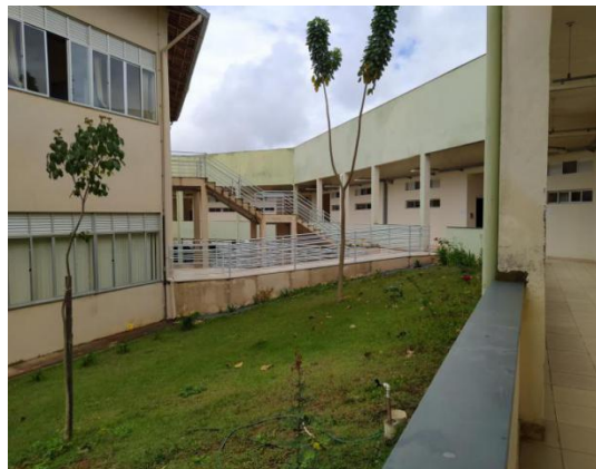
Figura 35: Fachada interna do prédio da Reitoria. Campus JK.
