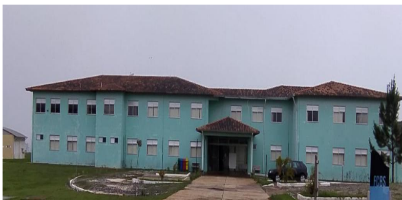
Figura 11: Fachada externa do Prédio da Fisioterapia – Campus JK.
