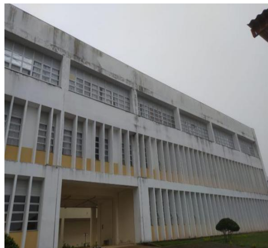
Figura 33: Fachada externa do prédio do ICT. Campus JK.
