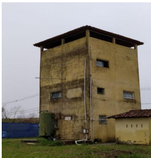
Figura 29: Fachada externa do prédio da Caixa D'água.
