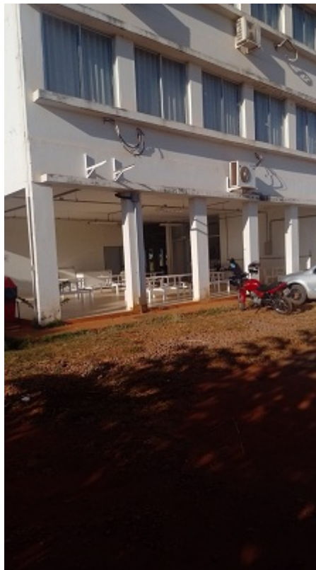
Área contígua com refeitório para usuários
