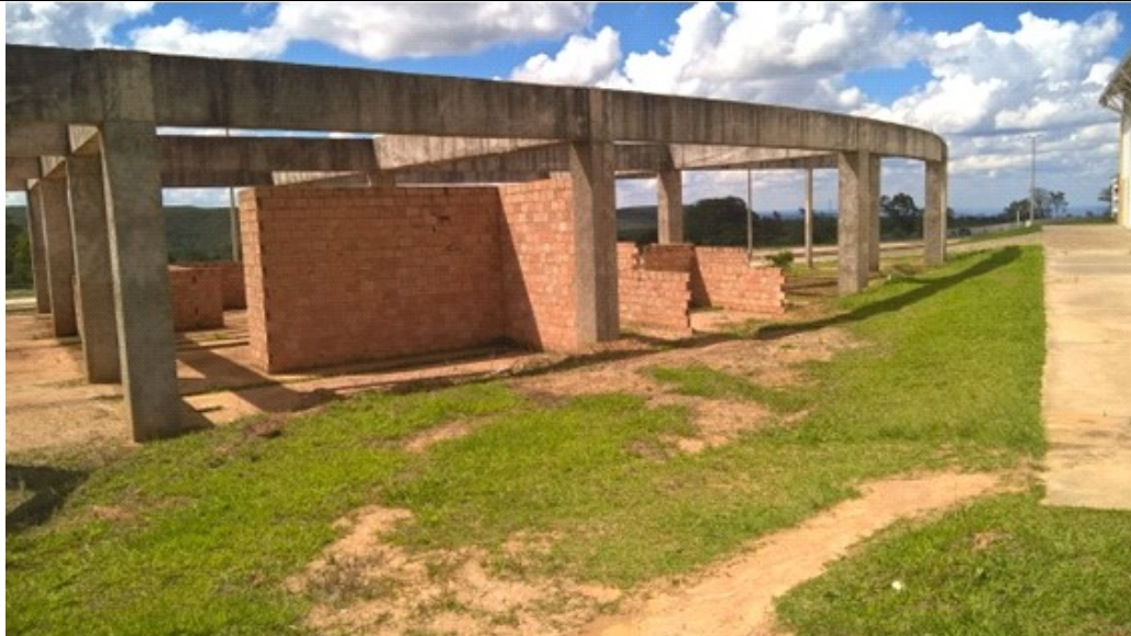
Figura 11: Vista do conjunto construído. Pilares e vigas a serem preservados. Parcela de alvenaria será demolida. No mesmo local da imagem, há piso em concreto que será objeto de demolição.
