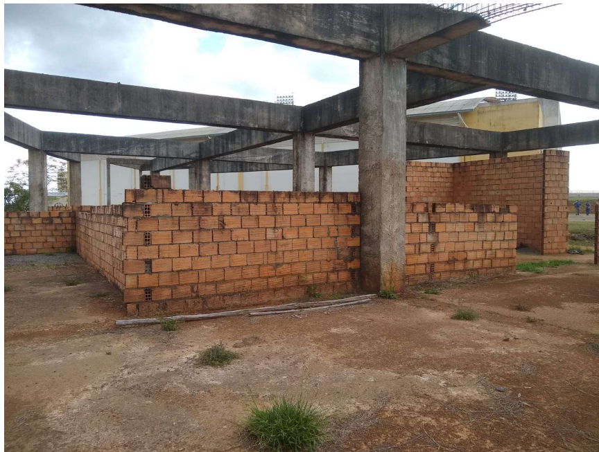
Figura 04: Alvenaria existente a demolir.
