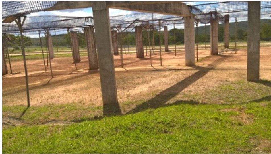
Figura 11: Vista do conjunto construído. Pilares e vigas a serem preservados. Parcela de alvenaria será demolida. No mesmo local da imagem, há piso em concreto que será objeto de demolição.
