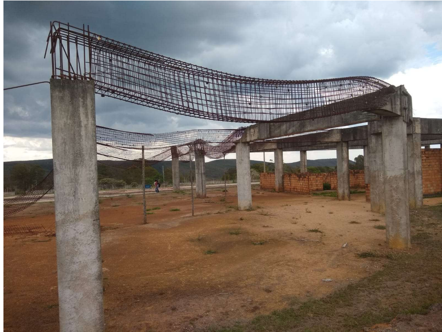
Figura 02: Componentes estruturais existentes.
