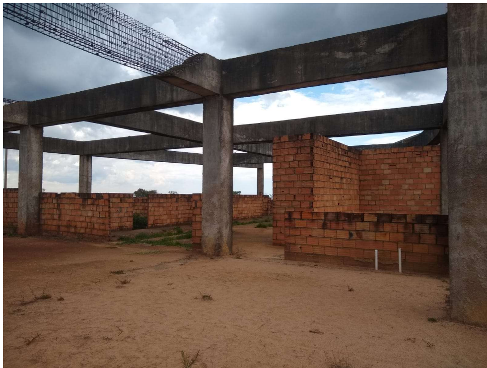
Figura 05: Alvenaria existente a demolir.
