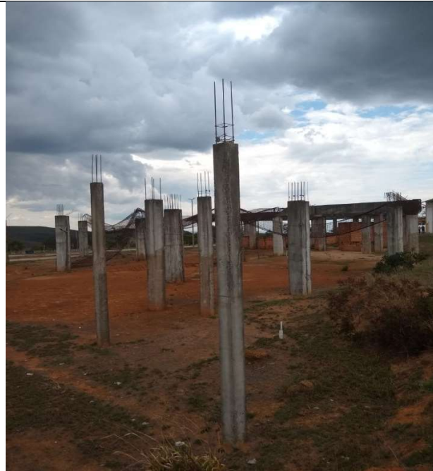
Figura 10: Vista do conjunto construído. Em destaque, pilares construídos.
