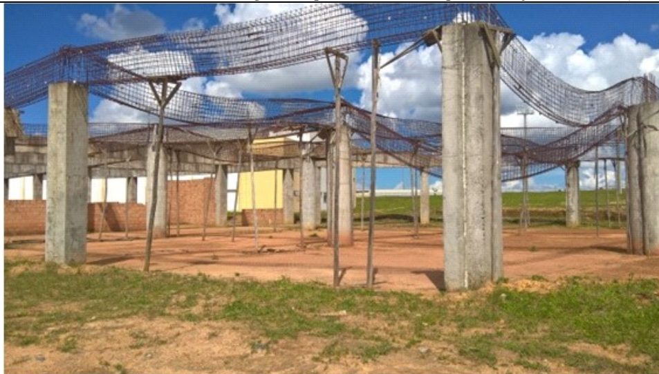
Figura 11: Vista do conjunto construído. Pilares e vigas a serem preservados. Parcela de alvenaria será demolida. No mesmo local da imagem, há piso em concreto que será objeto de demolição.
