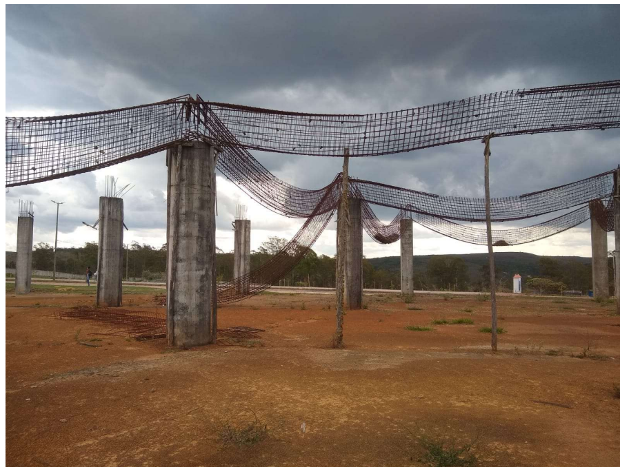
Figura 03: Componentes estruturais existentes.
