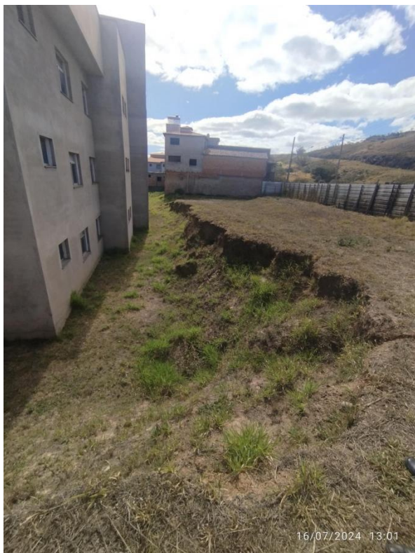
Fotos 24 e 25: Talude a ser recomposto e vegetação avançando nas instalações hidráulicas.
