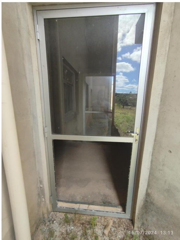
Fotos 20 e 21: Vidro da porta quebrado e tampa de caixa de passagem quebrada.
