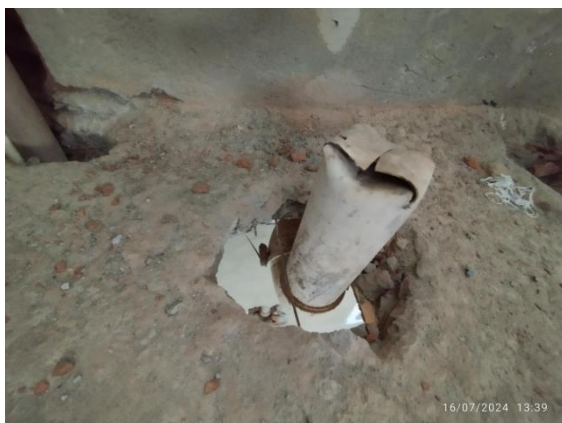
Fotos 06 e 07: Corte na laje para acomodar tubulação e grelhas da rede pluvial instaladas.
