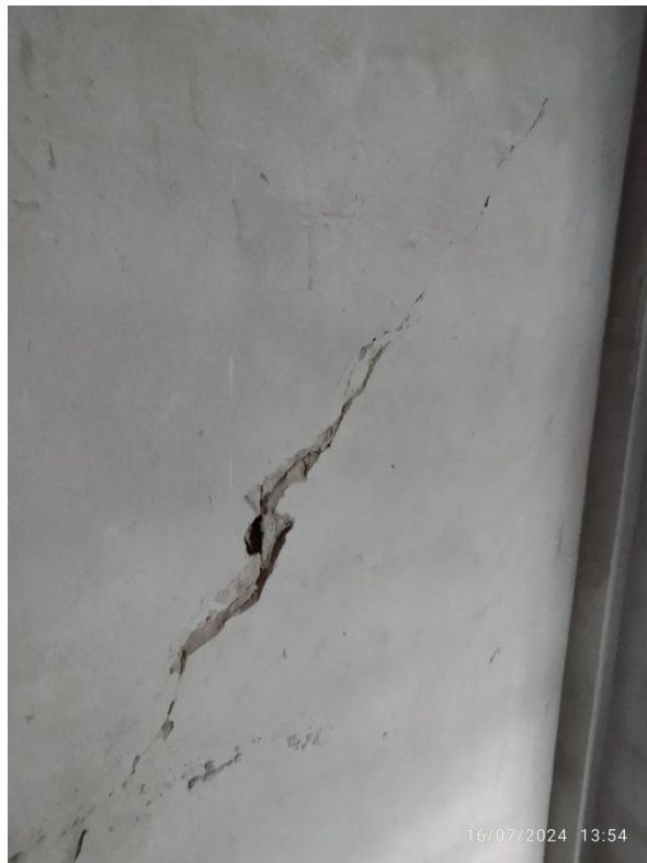
Fotos 18 e 19: Fissura na fachada externa e trinca dentro de um dos dormitórios.
