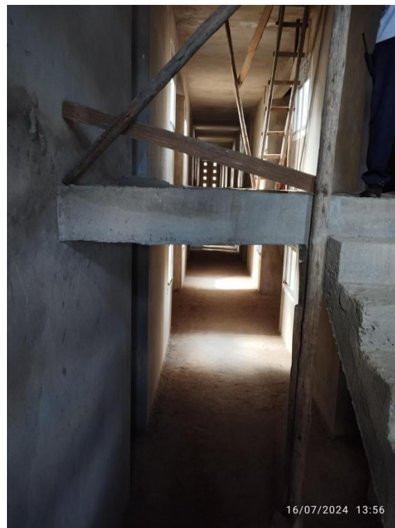
Fotos 10 e 11: Circulações pendentes a instalação de corrimãos, guarda corpo, sistema de prevenção, alarme e combate a incêndio, contrapiso e revestimentos.
