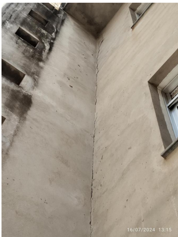
Fotos 18 e 19: Fissura na fachada externa e trinca dentro de um dos dormitórios.
