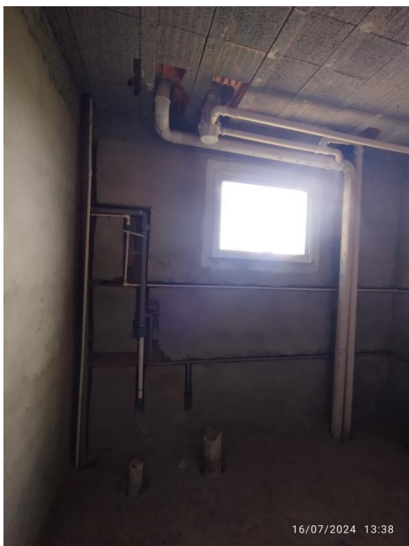
Fotos 02 e 03: Lançamento de tubulações.
