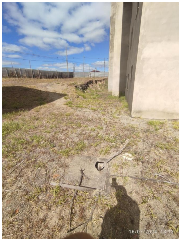
Fotos 20 e 21: Vidro da porta quebrado e tampa de caixa de passagem quebrada.
