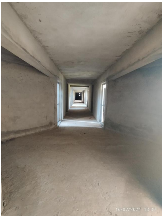
Fotos 10 e 11: Circulações pendentes a instalação de corrimãos, guarda corpo, sistema de prevenção, alarme e combate a incêndio, contrapiso e revestimentos.
