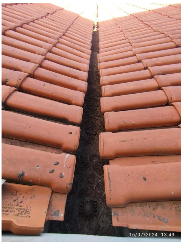
Fotos 22 e 23: Calhas com muito material depositado e telha quebrada.
