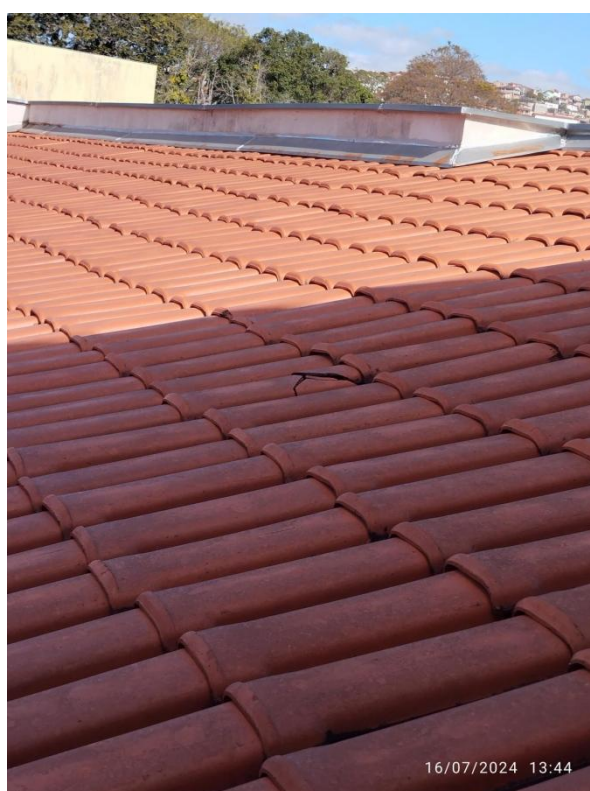
Fotos 22 e 23: Calhas com muito material depositado e telha quebrada.
