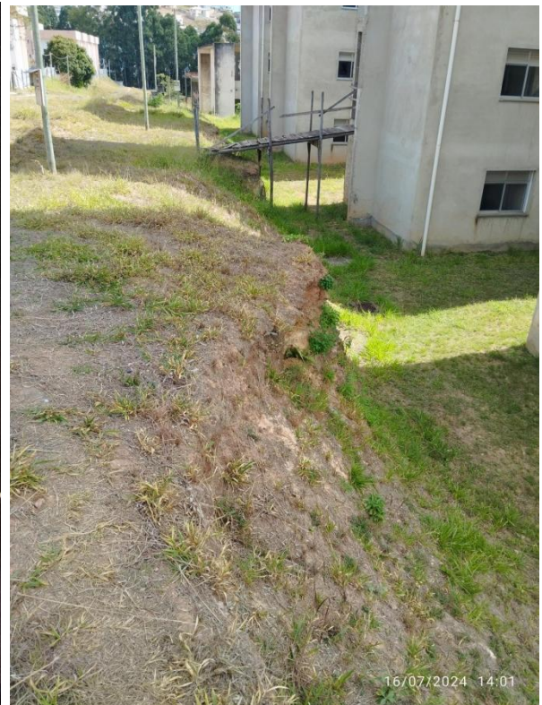
Fotos 30 e 31: Acesso previsto para o prédio no projeto de urbanização através de rampa, onde o desnível deveria ser menor e acesso sugerido paralelo ao prédio.
