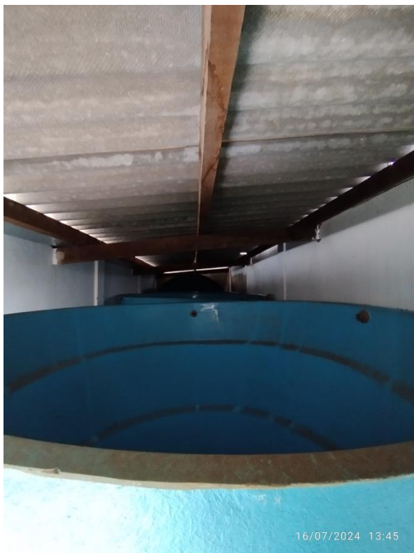
Fotos 08 e 09: Caixas d'água sem tampas e cobertura do prédio.
