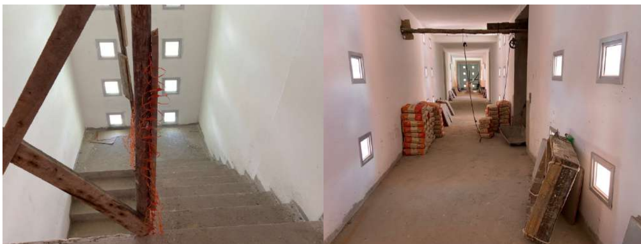
Foto 122: ESCADA 2º PAV.
