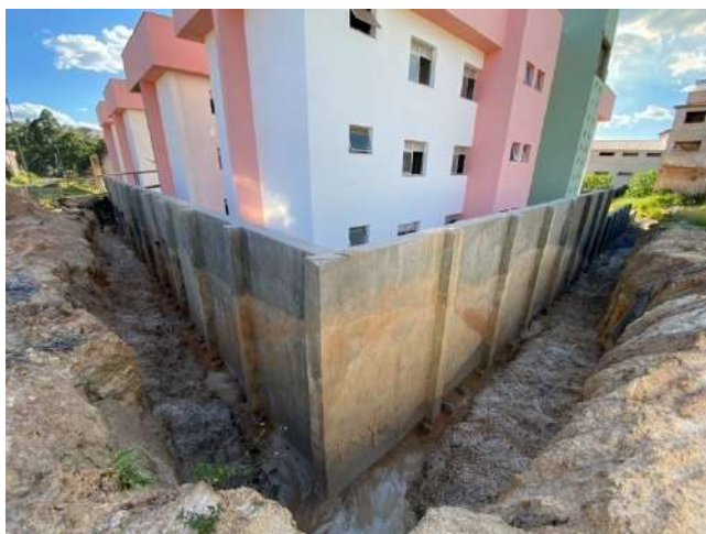
Foto 393: LATERAL DO MURO DE ARRIMO
