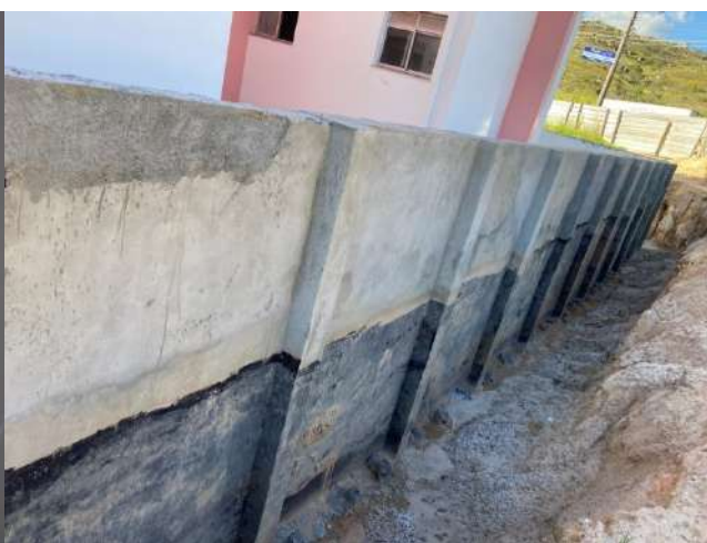
Foto 392: FRENTE DO MURO DE ARRIMO
