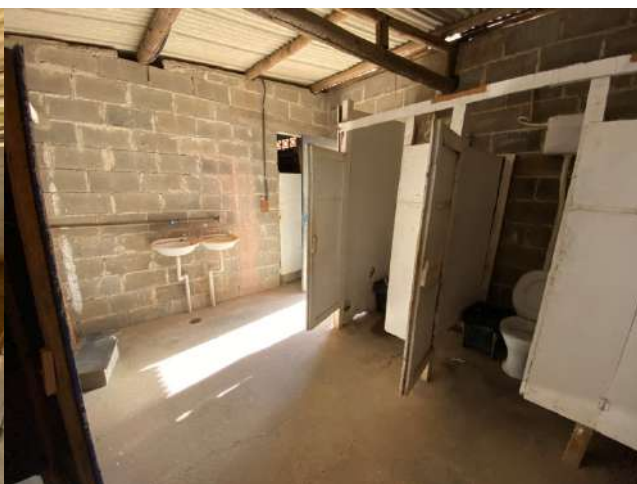
Foto 397: BARRACÃO DE OBRAS - BANHEIRO
