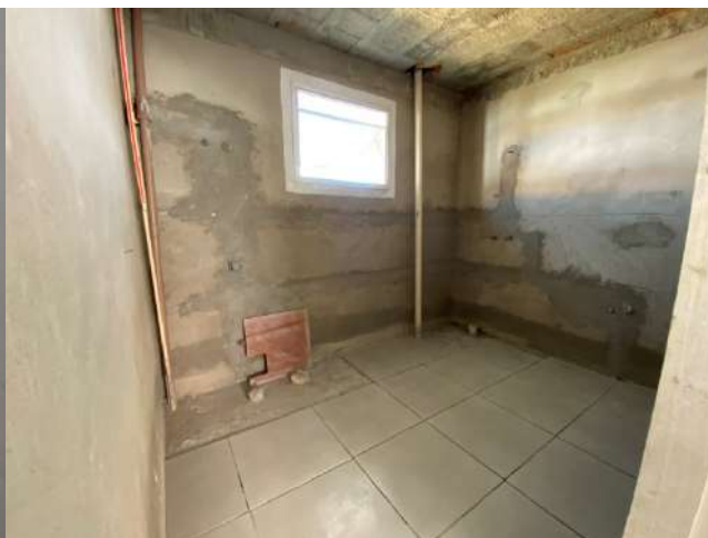
Foto 03: BANHEIRO PNE A314
