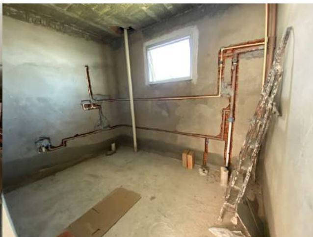
Foto 16: BANHEIRO PNE A301
