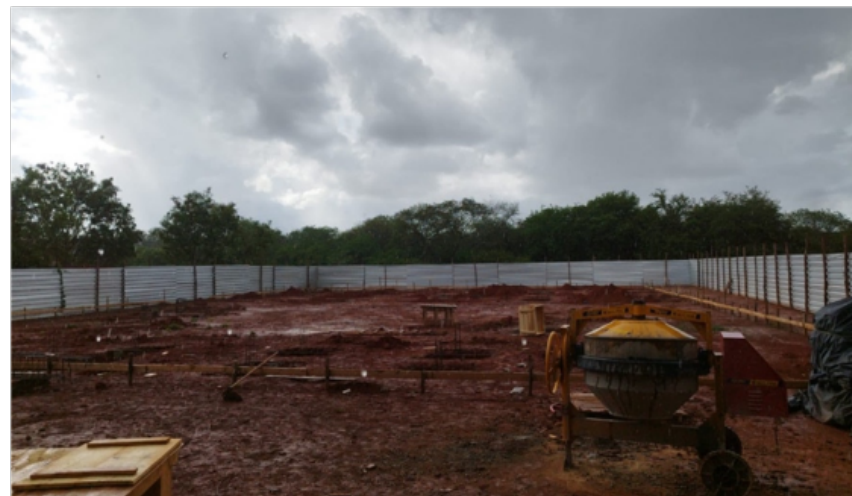
Imagem 19: Obra do Refeitório - Campus Janaúba Fonte: Diretoria de Obras e Serviços de Engenharia (2025)
