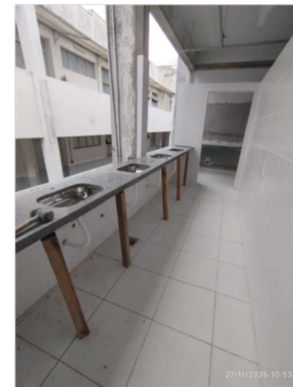
Imagem 02: Reforma - Campus I Fonte: Diretoria de Obras e Serviços de Engenharia (2025)
