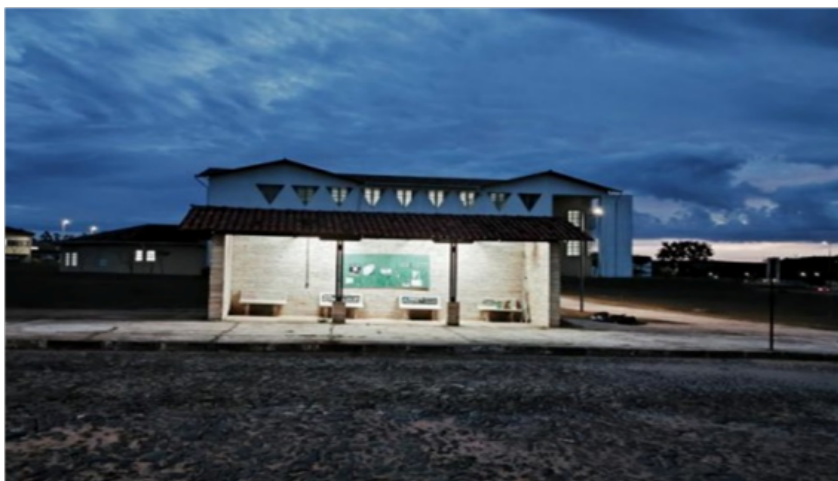
Imagem 05: Iluminação e instalação de tomadas nos pontos de ônibus– Campus JK Fonte: Diretoria de Obras e Serviços de Engenharia (2025)
