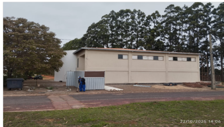
Imagem 07: Manutenção do Prédio do Almojarifado– Campus JK Fonte: Diretoria de Obras e Serviços de Engenharia (2025)
