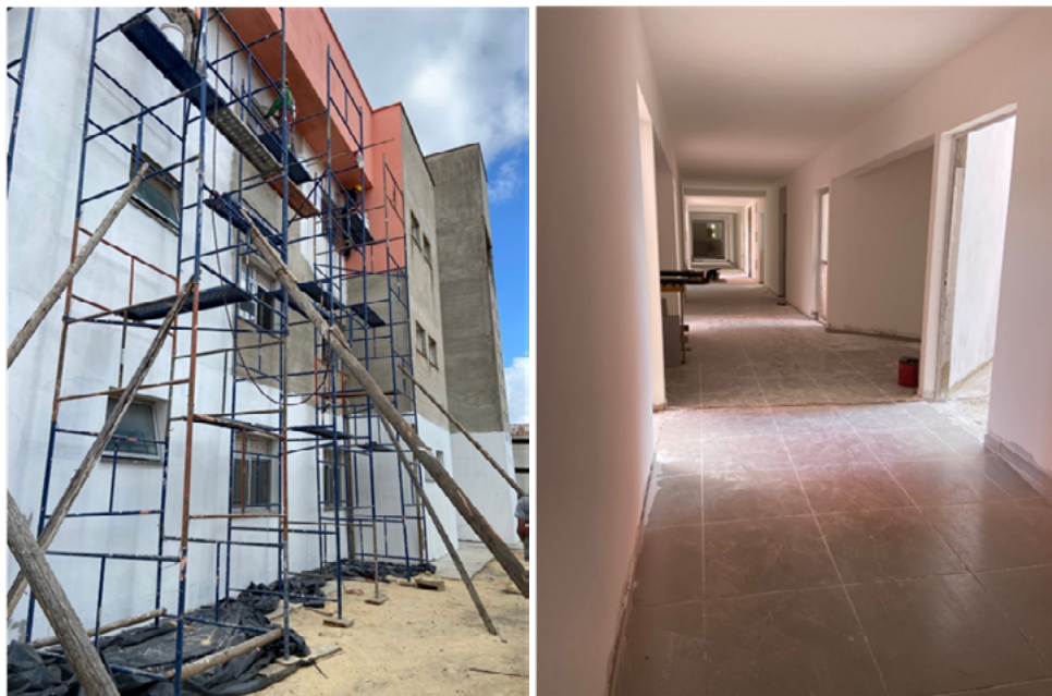
Obras na Moradia Estudantil – Bloco IV Fonte: Diretoria de Obras e Serviços de Engenharia (2025).
