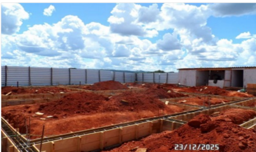
Imagem 21: Obra do Refeitório – Campus Unai Fonte: Diretoria de Obras e Serviços de Engenharia (2025)
