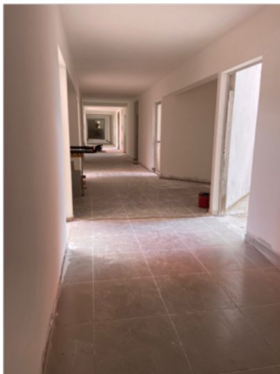
Imagem 09: Obras na Moradia Estudantil – Bloco IV
