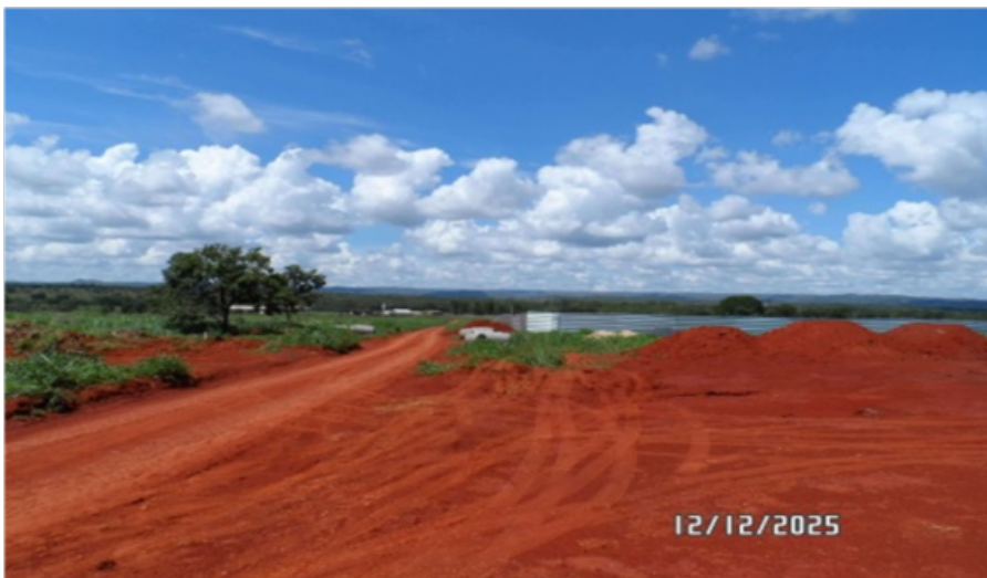
Imagem 20: Obra de Urbanização do Campus Unai Fonte: Diretoria de Obras e Serviços de Engenharia (2025)
