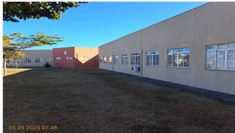
Imagem 06: Manutenção do Prédio da Agronomia– Campus JK Fonte: Diretoria de Obras e Serviços de Engenharia (2025)
