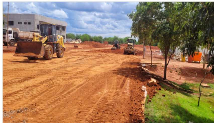
Imagem 18: Obra de Urbanização do Campus Janaúba Fonte: Diretoria de Obras e Serviços de Engenharia (2025)
