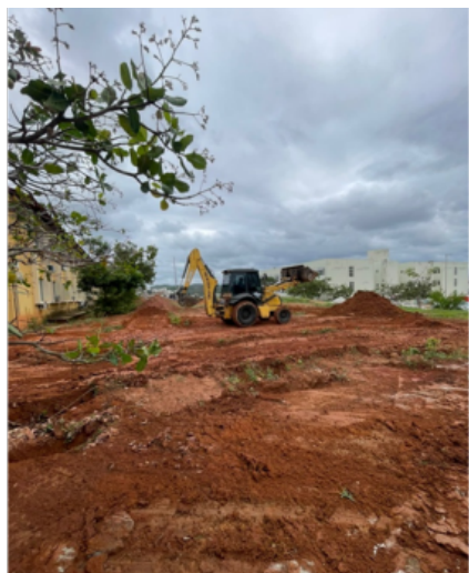
Imagem 16: Obra de construção do Prédio da Fammuc - Campus do Mucuri Fonte: Diretoria de Obras e Serviços de Engenharia (2025)
