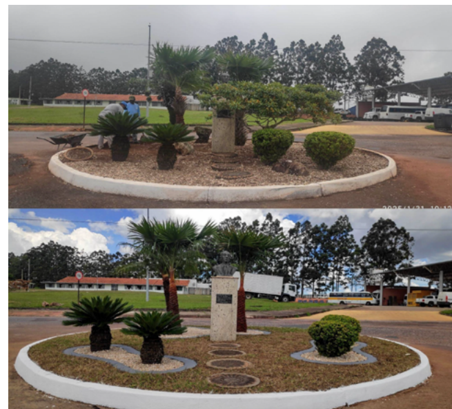
Figura 1 – Reforma da rotatória de acesso à avenida principal de entrada ao Campus JK, retratando o antes e depois
