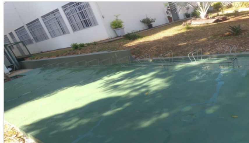
Imagem 12: Construção de Bicicletário – Prédio do ICET – Campus do Mucuri Fonte: Diretoria de Obras e Serviços de Engenharia (2025)
