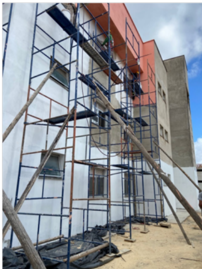
Imagem 08: Obras na Moradia Estudantil – Bloco IV
