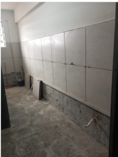
Imagem 11: Reforma de banheiros do prédio da Fammuc - Campus do Mucuri
