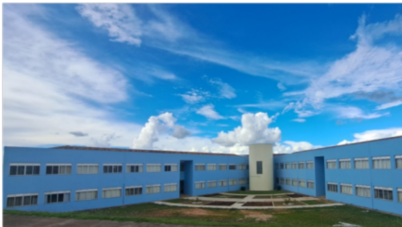
Imagem 04: Prédio da FIH – Pintura de fachadas e execução de área de convivência – Campus JK Fonte: Diretoria de Obras e Serviços de Engenharia (2025)
