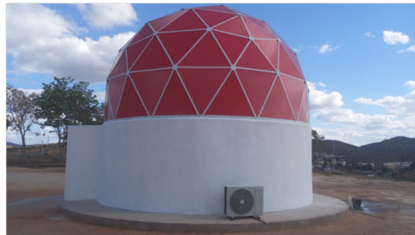
Imagem 13: Conclusão da obra do Planetário – Campus do Mucuri Fonte: Diretoria de Obras e Serviços de Engenharia (2025)
