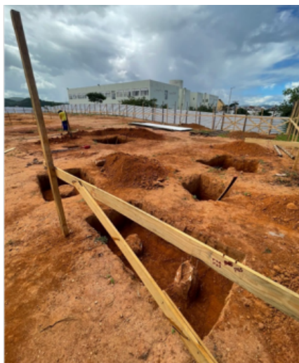
Imagem 17: Obra de construção do Prédio da Fammuc - Campus do Mucuri Fonte: Diretoria de Obras e Serviços de Engenharia (2025)
