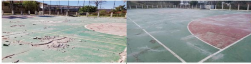
Figura 1: Antes da Revitalização
