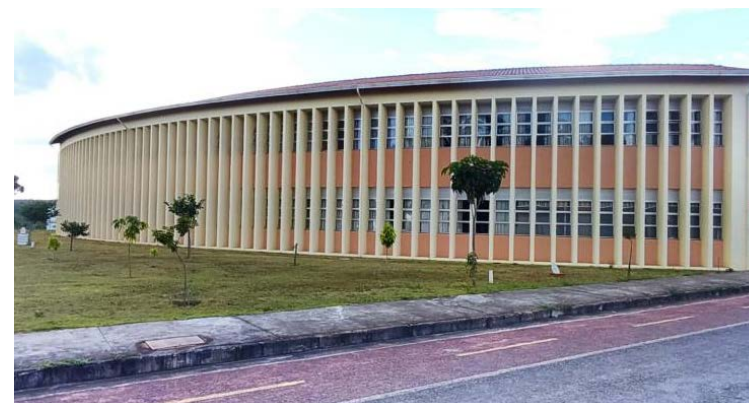
Setor administrativo, laboratórios e gabinetes dos docentes da Dead
