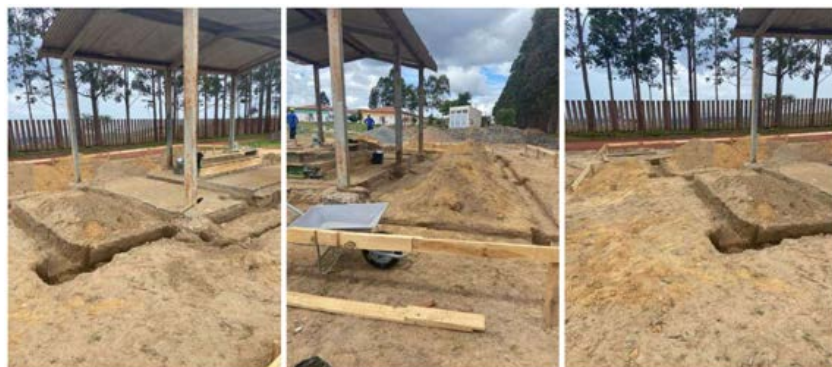
Início da obra de adequação do abrigo de Resíduos de Serviços de Saúde, no Campus JK
