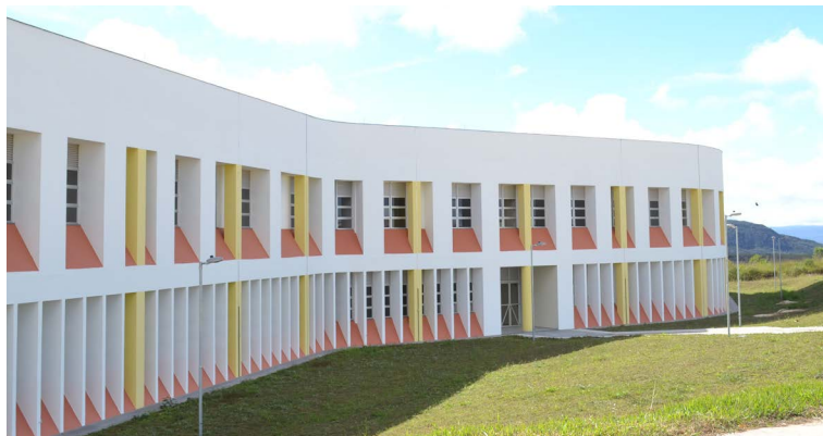
Setor administrativo, gabinetes docentes, salas de aula e laboratórios da FIH
