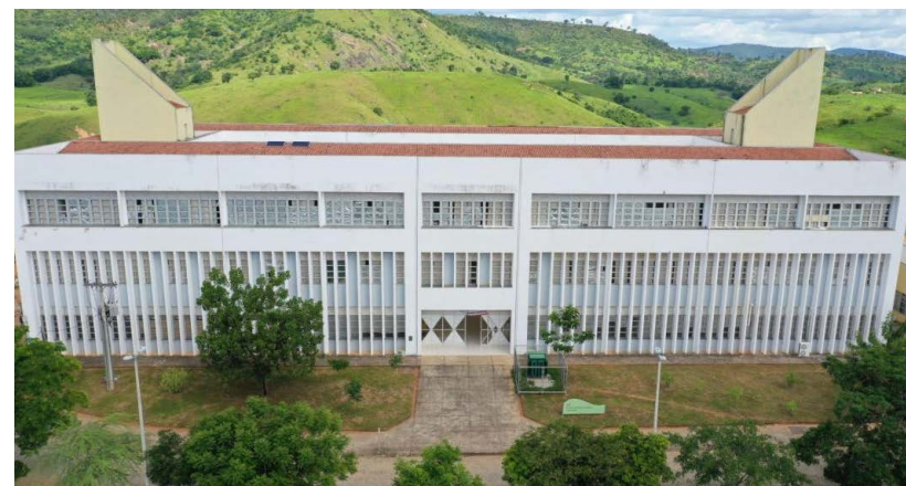
Prédio do Icet
