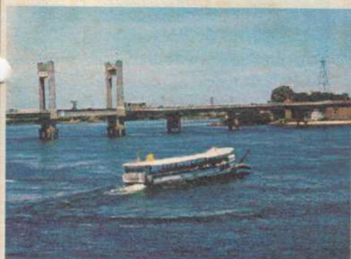
Ponte Presidente Dutra sobre o Rio São Francisco, que liga a cidade de Petrolina (PE) à cidade de Juazeiro (BA)
