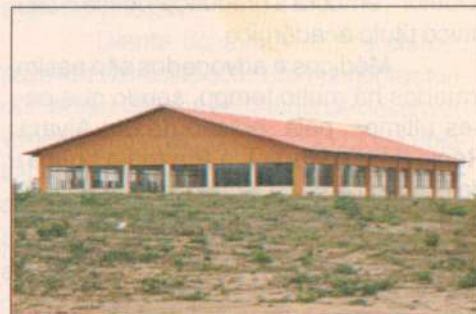
Já estão concluídas as obras do Restaurante Universitário do Campus II da Fafeid. Com uma área construída de 570 m², a obra do Restaurante teve um custo aproximado de R$ 306 mil. Os próximos passos serão mobiliar o Restaurante e definir a sua exploração.
