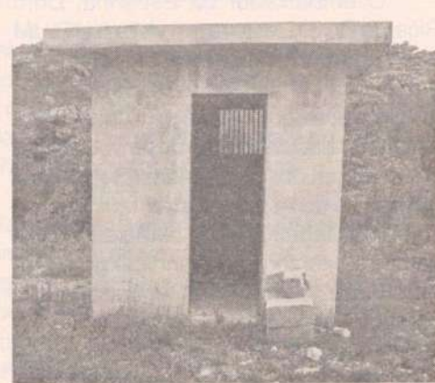
Casa de Máquinas para captação da água
