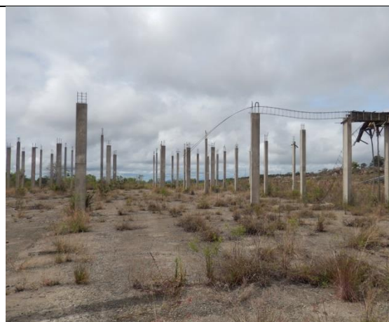
Foto 36 - Vista parcial do local da obra do prédio de tecnologia da madeira
