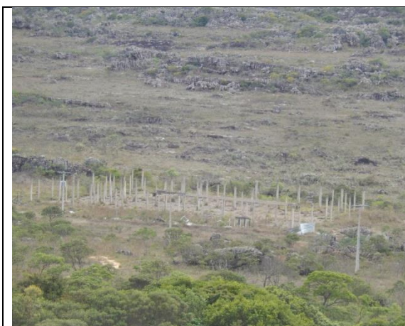
Foto 33 - Vista panorâmica do local da obra do prédio de tecnologia da madeira
