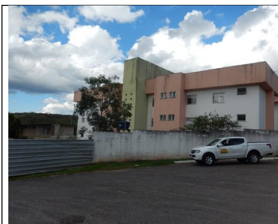
Foto 1- Vista do Conjunto 1 da Moradia Estudantil
