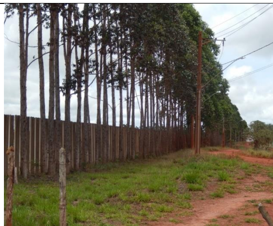
Foto 38 - Vista parcial do cercamento executado no entorno do Campus JK (lateral rua L)
