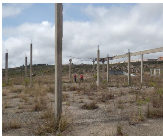
Foto 34 - Vista parcial do local da obra do prédio de tecnologia da madeira
