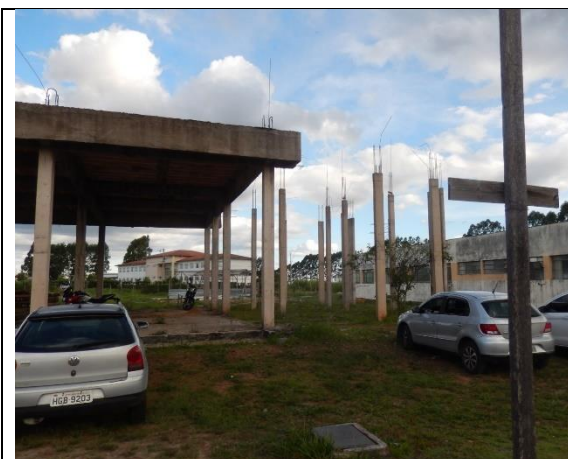
Foto 55 - Vista da estrutura do prédio do CITEC
