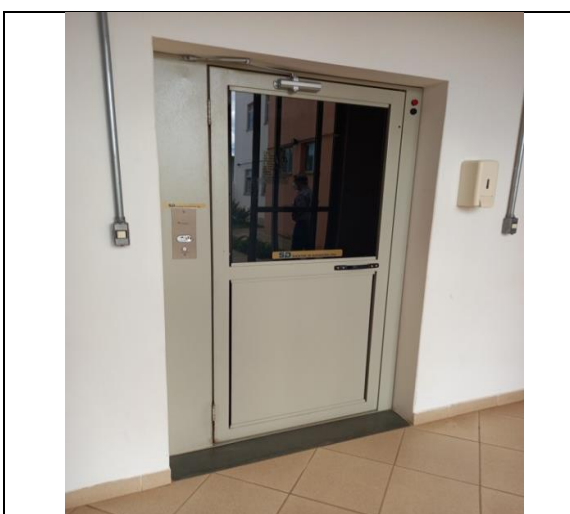
Foto 9- Vista de elevador na Moradia Estudantil
