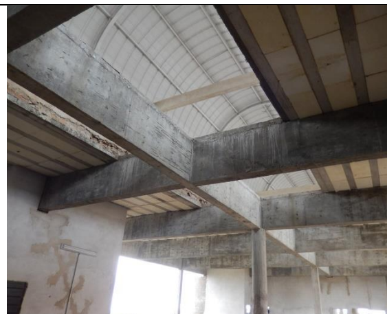
Foto 21- Vista da cobertura metálica do prédio da Odontologia
