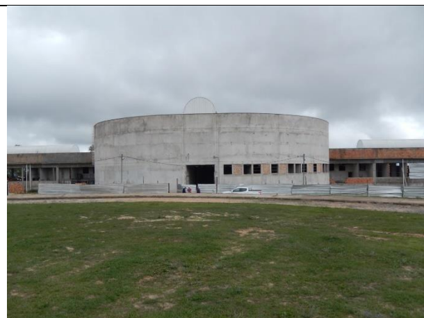
Foto 19- Vista frontal do prédio da Odontologia
