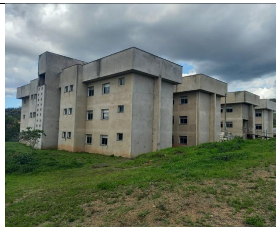
Foto 11- Vista do Conjunto 4 da Moradia Estudantil
