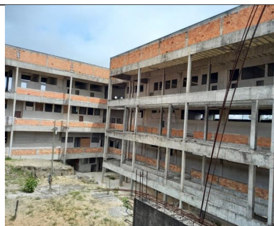
Foto 25 - Vista interna do prédio da Odontologia
