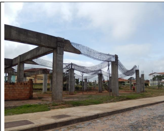
Foto 51 - Vista parcial da obra do Restaurante Universitário
