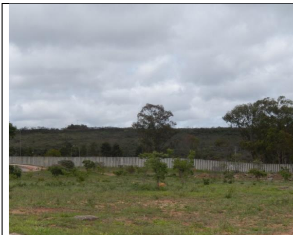
Foto 37 - Vista parcial do cercamento executado no entorno do Campus JK (lateral BR367)
