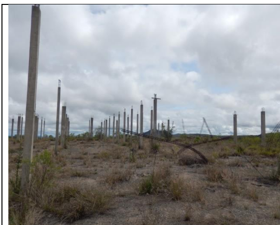
Foto 35 - Vista parcial do local da obra do prédio de tecnologia da madeira
