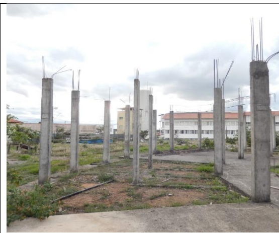
Foto 58 - Vista parcial da obra do prédio da Faculdade de Ciências Agrárias
