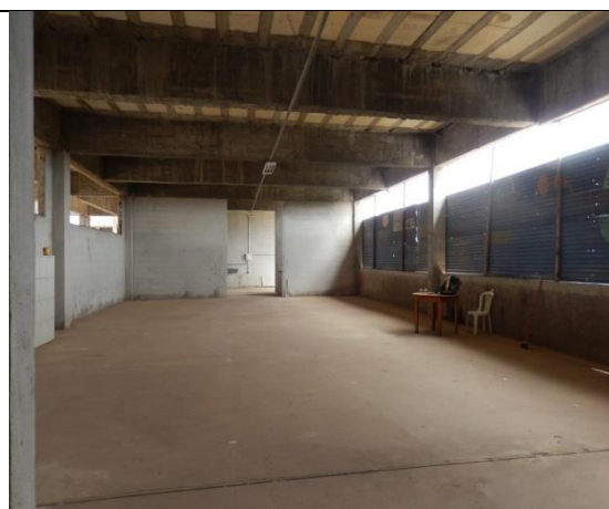
Foto 26 - Vista interna do prédio da Odontologia
