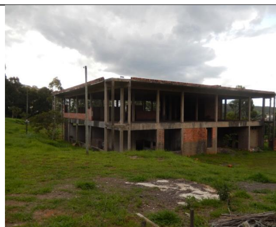
Foto 15- Vista do Conjunto 6 da Moradia Estudantil
