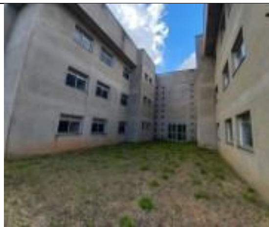
Foto 12- Vista do Conjunto 4 da Moradia Estudantil
