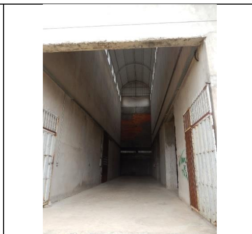
Foto 20- Entrada principal do prédio da Odontologia
