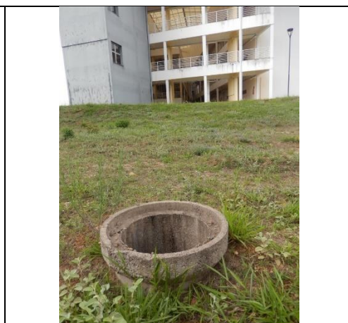
Foto 32 - Vista do ponto de visita, sem tampa, localizado próximo ao prédio da Medicina e ponto final da obra antes da paralisação
