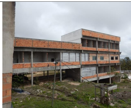
Foto 23 - Vista da ala lateral do prédio da Odontologia
