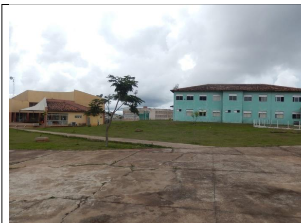
Foto 31 - Vista de 2 pontos de visita localizados na Av. A e próximo ao Departamento de Nutrição
