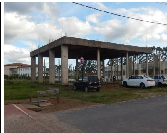
Foto 53 - Vista da estrutura do prédio do CITEC
