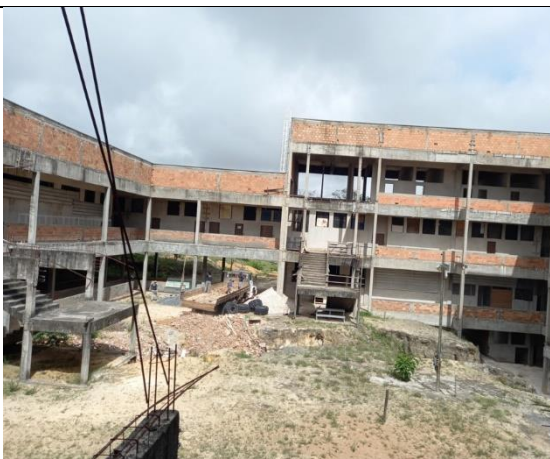
Foto 24 - Vista interna do prédio da Odontologia
