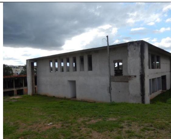
Foto 17- Vista do Conjunto 7 da Moradia Estudantil
