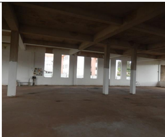
Foto 18- Vista interna do Conjunto 7 da Moradia Estudantil
