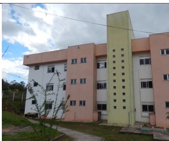
Foto 2- Vista do Conjunto 2 da Moradia Estudantil
