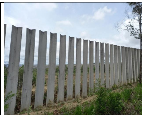
Foto 41 - Vista parcial do cercamento executado no entorno do Campus JK
