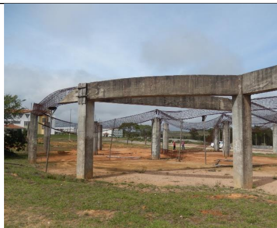
Foto 52 - Vista parcial da obra do Restaurante Universitário
