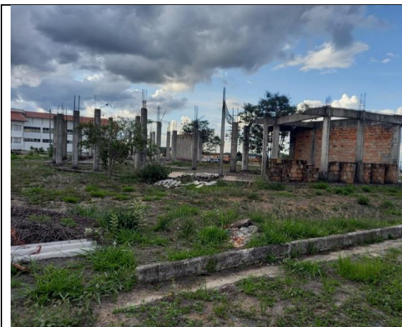
Foto 57 - Vista parcial da obra do prédio da Faculdade de Ciências Agrárias
