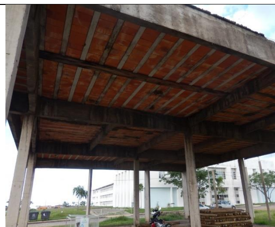
Foto 56 - Vista das vigas e pilares da estrutura do prédio do CITEC
